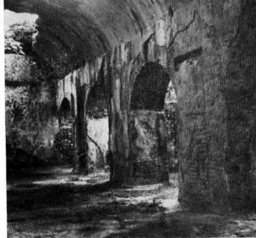
17. Navata a monte della «contecta cisterna» con la volta in parte lacunosa
