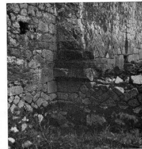
22. Grossa lesena lapidea (con base sagomata) sull'estremo limite orientale della banchina, addossata al muraglione, fra la corte a S nel fondovalle e la contigua cala a N sul mare
