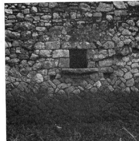
21. Bocca quadrata (m. 0,40 di lato), dalla semplice e forte cornice architettonica, del canale lapideo di scolo delle acque del pendio orientale, aperta nel muraglione nell'area della cala
