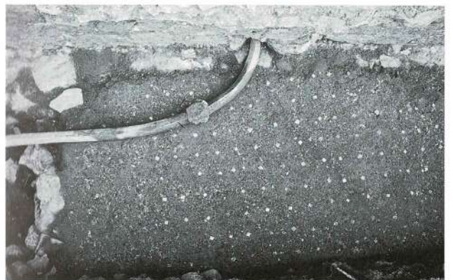
Fig. 12 - Varignano Vecchio (SP). Edificio presillano. Vano 3.
