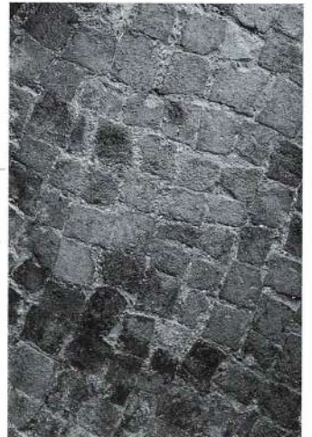
Fig. 15 - Varignano Vecchio (SP). Edificio presillano. Vano 1.
