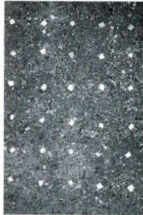
Fig. 17 - Edificio presillano. Particolare della pavimentazione del vano 3.
