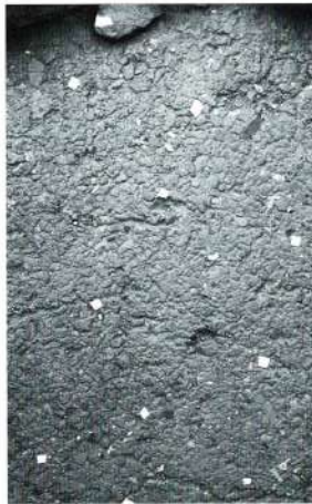
Fig. 22 - Edificio presillano. Particolare della pavimentazione del vano 2.
