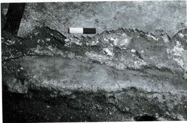
Fig. 6 - Varignano Vecchio (Sp). Pars abitativa . Strati preparatori del mosaico dell'ala 15.
