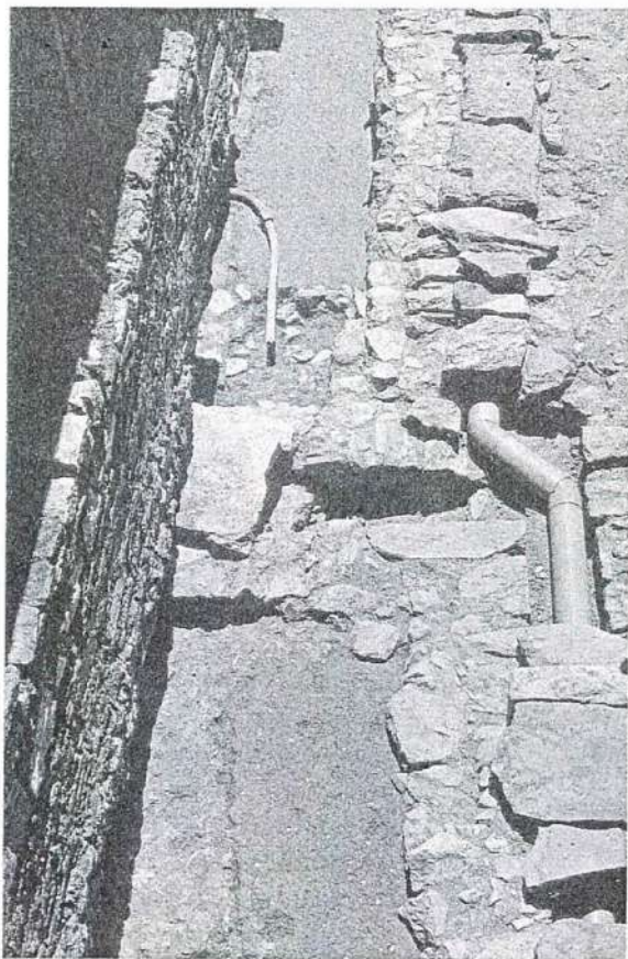
Fig. 6. Varignano Vecchio. Particolare dell'utilizzazione della rete idrica di età romana per il convogliamento delle acque.
