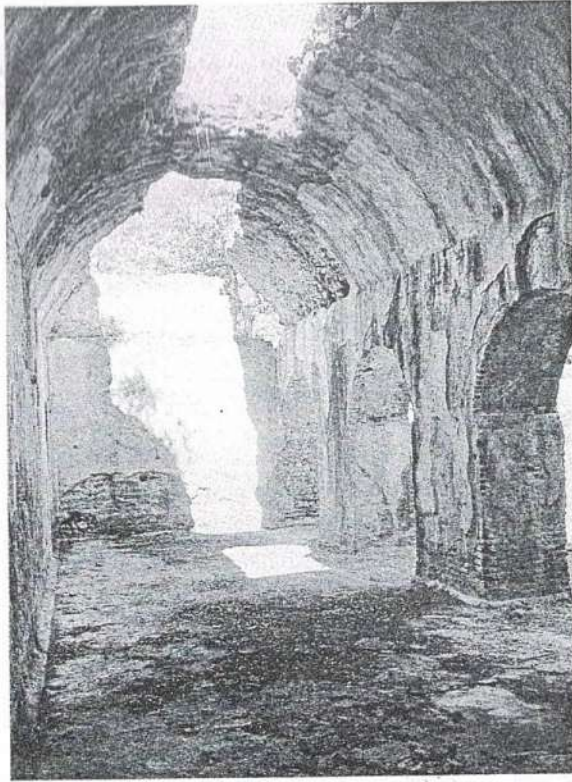
Fig. 10. Varignano Vecchio. Contacta cisterna. La fabbrica antica prima degli interventi di restauro (navata a monte).
