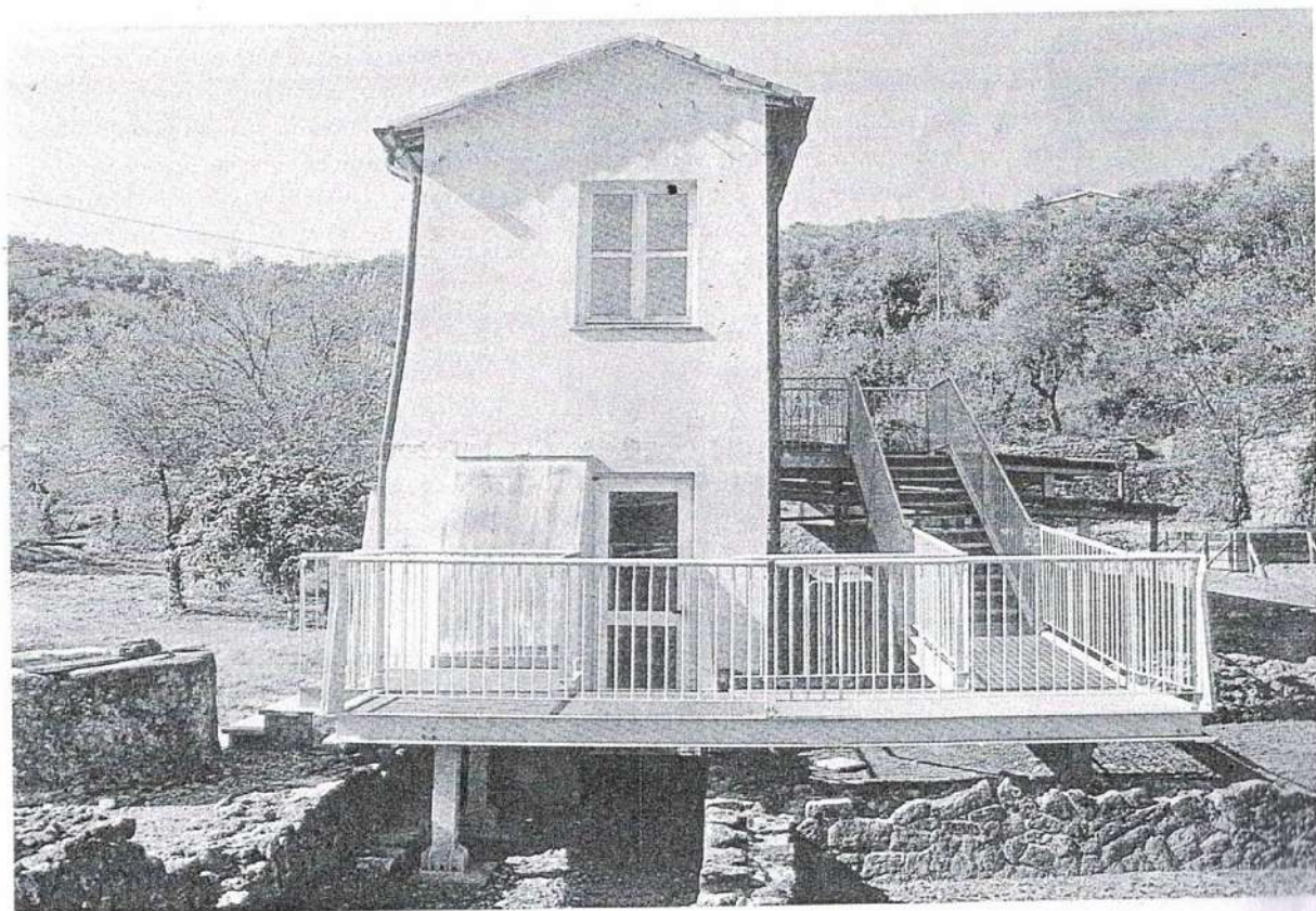
Fig. 9. Varignano Vecchio. Casale Liverani. Particolare delle murature di età romana e delle strutture di accesso al casale.
