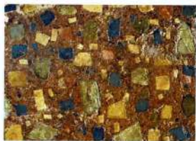
fig. 5a e 5b Particolari delle pavimentazioni.
